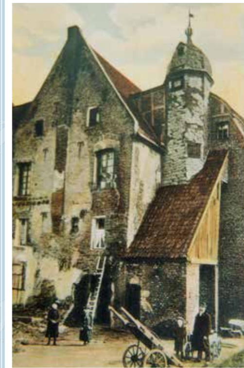
Rückseite des alten Zollhauses aus 1635. Umbauten erfolgten 1913 und 1967
