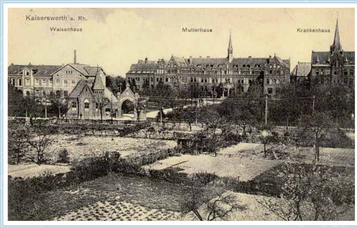
Blick auf die „Neue Diakonie“ 1917 auf dem hochwassersicheren Fronberg mit dem Pförtnerhaus (das Tor fehlt heute). Auf der damals noch freien Fläche zwischen Alte Landstraße und Klemensplatz wurde in den Kriegs- und Notjahren Gemüse angebaut.
