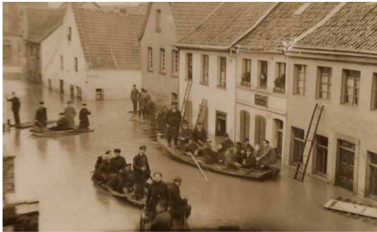
Hochwasser An St. Swibert, Haus Nr. 46 bis 50, im Januar 1920
