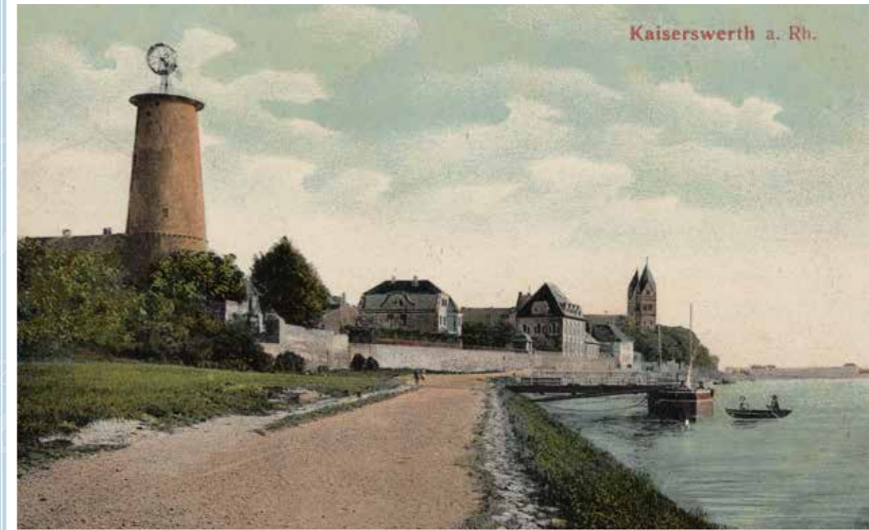
Die Uferpromenade (Leinpfad nach Wittlaer) 1918. Das kleine Windrad auf dem Mühlenturm diente zum Antrieb einer Pumpe für die Wasserversorgung des Diakoniewerks.
