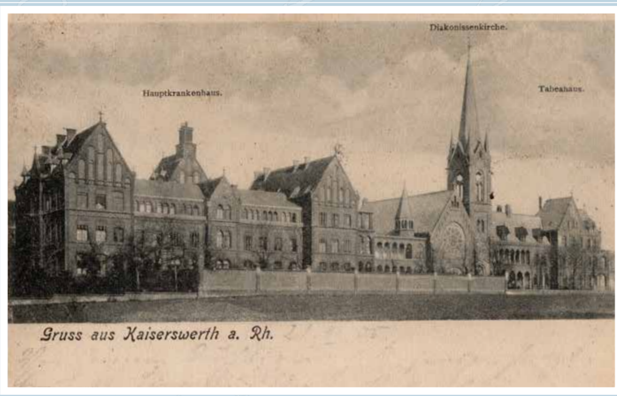
Ansicht der „Neuen Diakonie“ von Süden (Zeppenheimer Weg) 1905. Die Turmspitze der Mutterhauskirche musste nach dem 2. Weltkrieg auf Veranlassung der englischen Besatzung als Luftfahrthindernis abgetragen werden.
